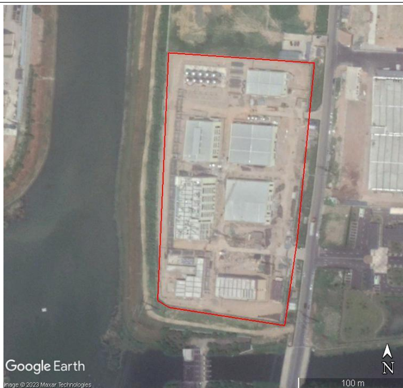
2019 年 7 月 地块内润禾有机硅厂房建设中。
