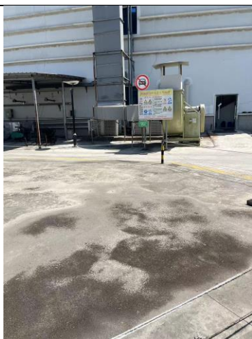
初期雨水收集池
