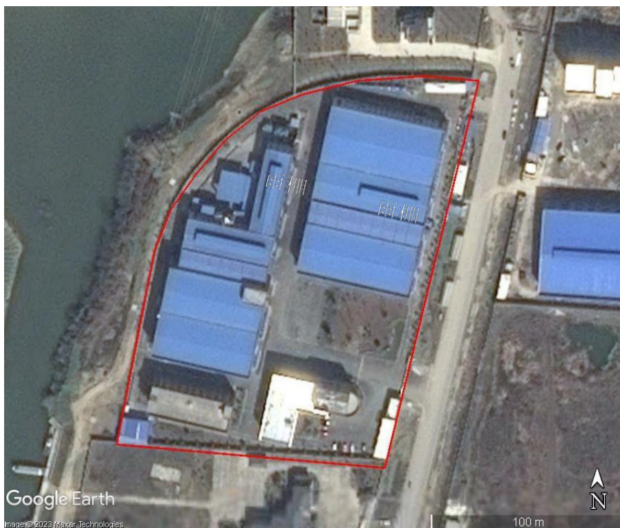
2013 年 3 月 地块内北侧 2 个厂房中间搭建雨棚，西南侧停车棚占地区域增大。
