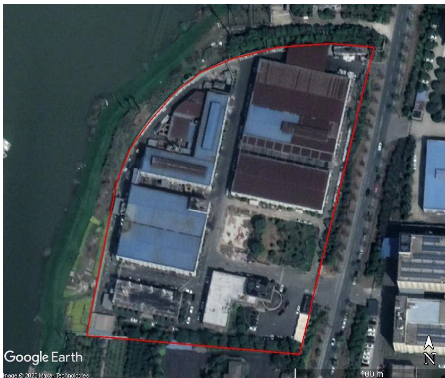
2022 年 3 月 地块内中部偏南侧应急池建设。
