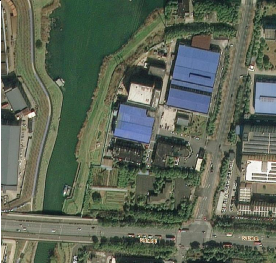
2025 年 1 月 西北角已新建车间、变电房
