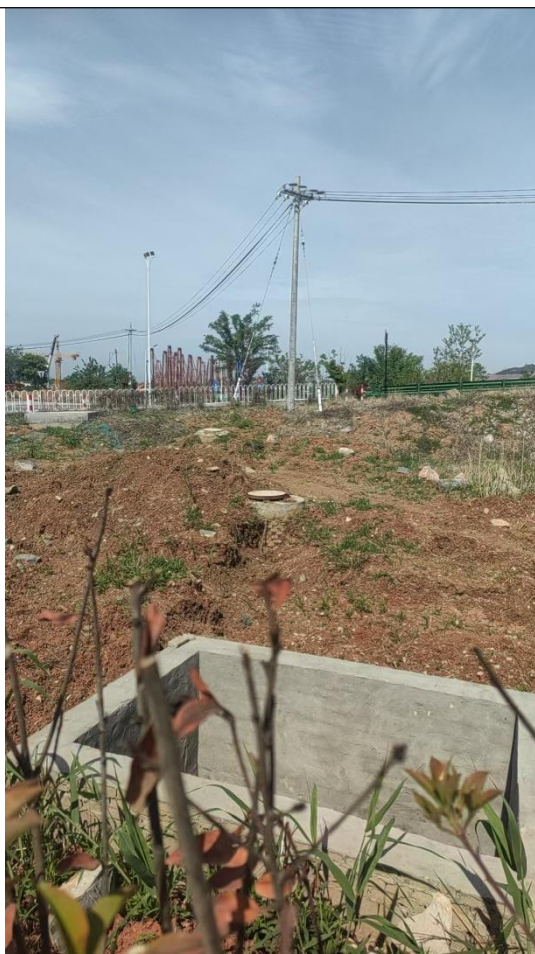
图 3-9 生活污水排放口
