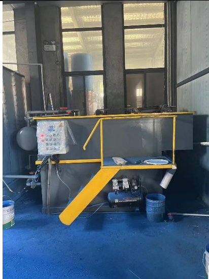
图 3-2 废水处理设施现状
