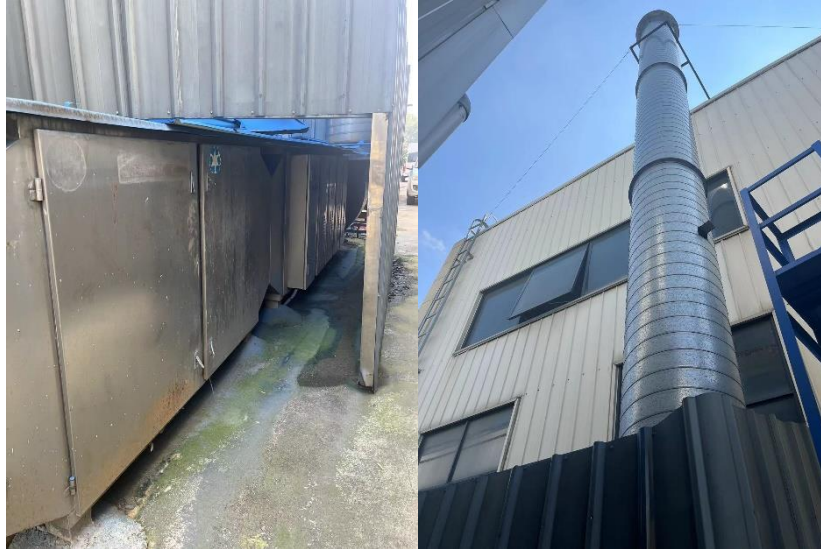
图 3-5 废气收集处理现状
